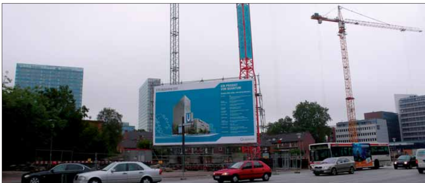
Die Baustelle für den neuen Riesenklötz am Steindamm
