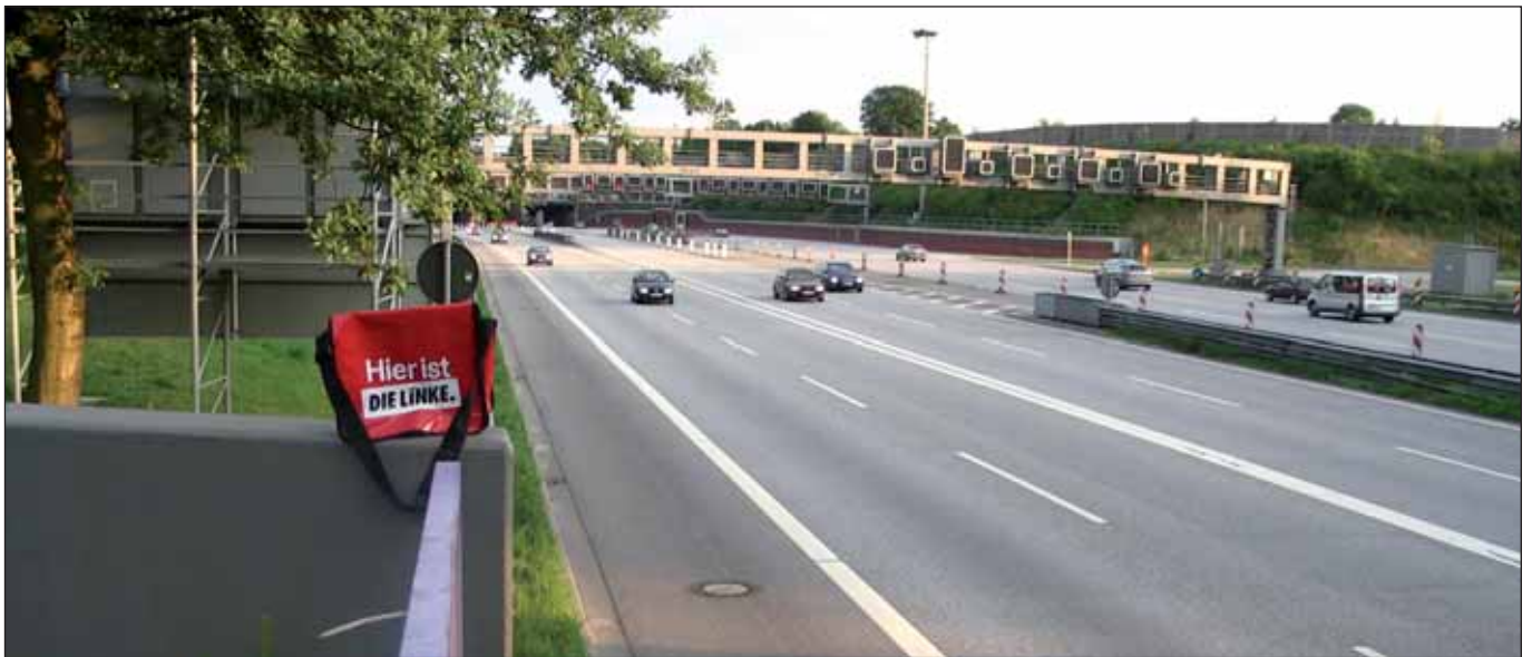
Autobahn 7 in Bahrenfeld: Kleingärten gedeckelt?
