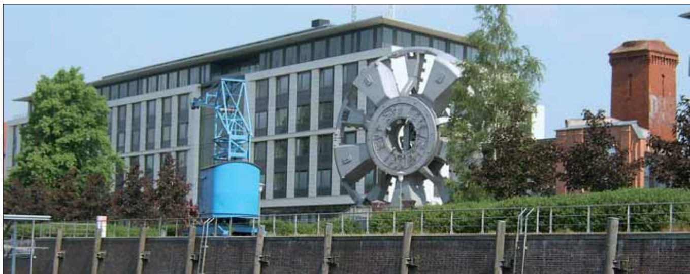
SAGA GWG-Zentrale neben dem Museum der Arbeit
